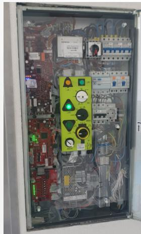
La maniobra de última generación se instala en el armario existente, garantizando la máxima fiabilidad y suministro de repuestos a largo plazo.
